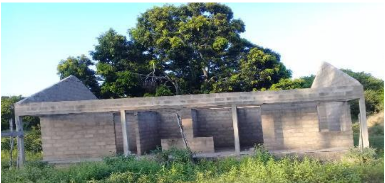
Beginn der Bauarbeiten
